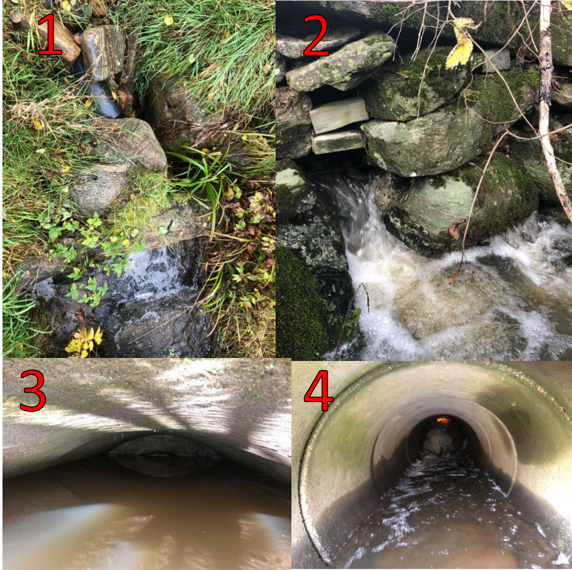
Figur 5 Bilder tagna på vandringshinder från traktorövergångar
