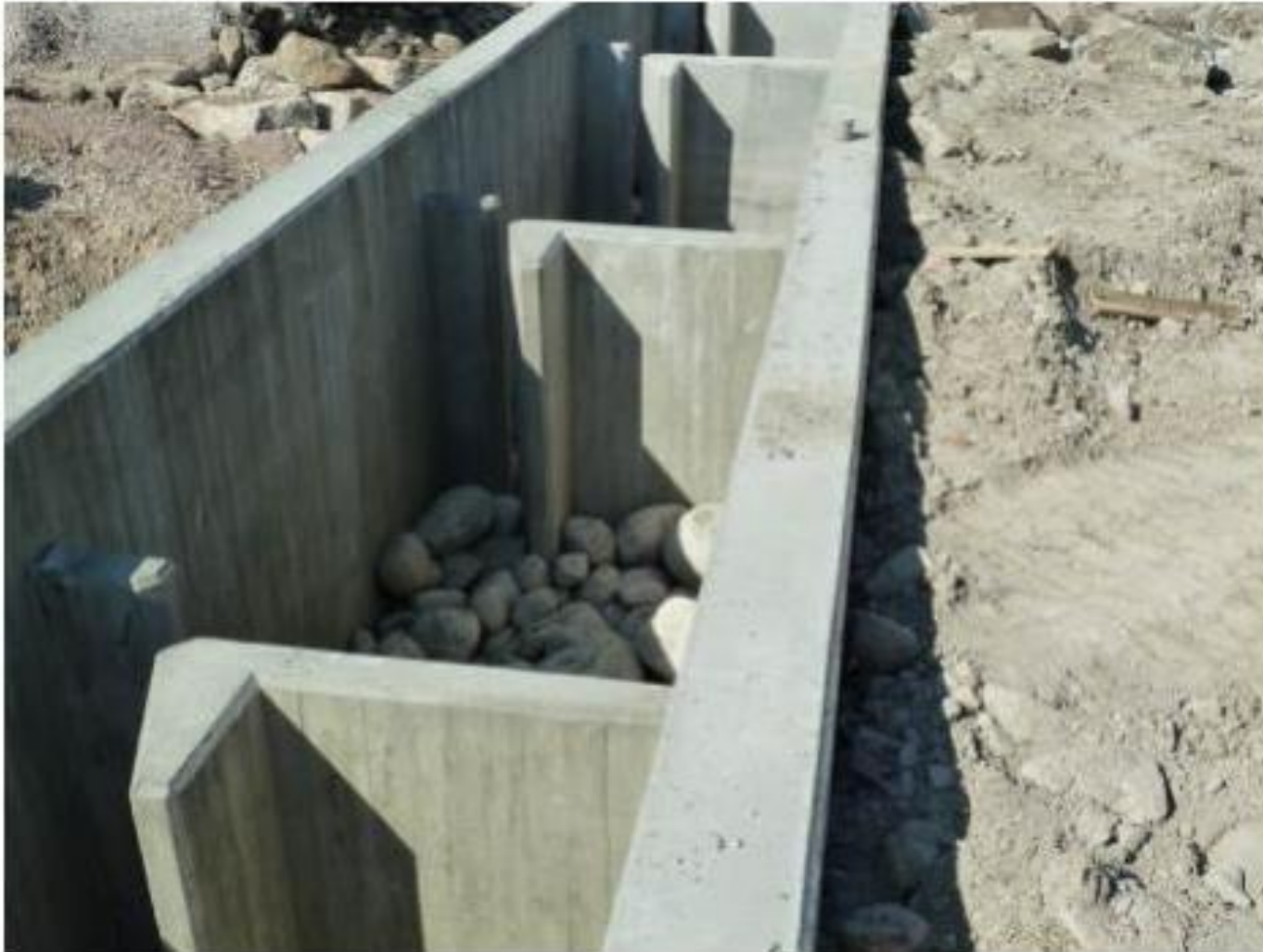
Figur 21. Exempel på slitsränna med 13 cm fallhöjd mellan bassängerna från Kallstena kraftverk vid Hedströmmen.
