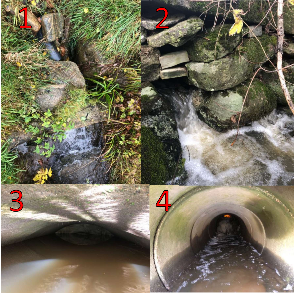
Figur 5 Bilder tagna på vandringshinder från traktorövergångar
