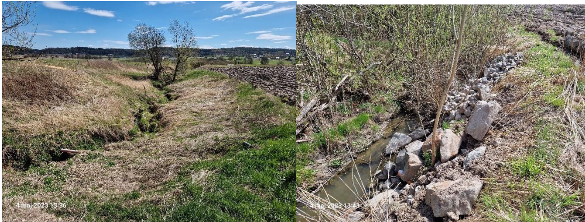
Figur 2a & b. Bäcken är djupt nedskuren dräneringsrör ligger ca 1 m över vattennivån (fig.2a) Fig 2b. visar ett erosionsskydd som lagts i ett försök att stoppa erosionen ut mot den närliggande åkern med obefintlig skyddszon.
