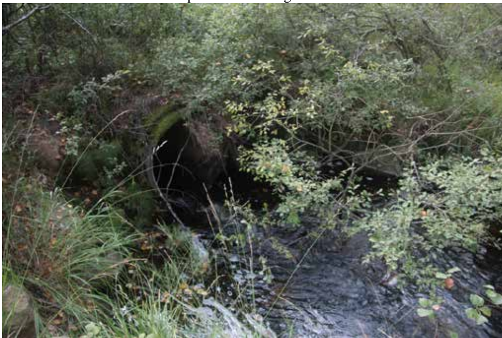
Figur 118. Hinder 2 i Svartåbäcken. En felaktigt placerad vägtrumma med fri ände.
