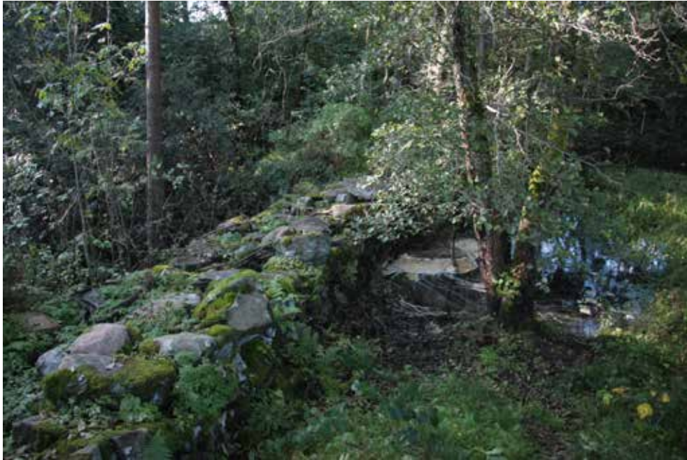
Figur 55. Hinder 2 sett från sidan och ovan dammen. Dammens vattenspegel syns till höger i bilden.
