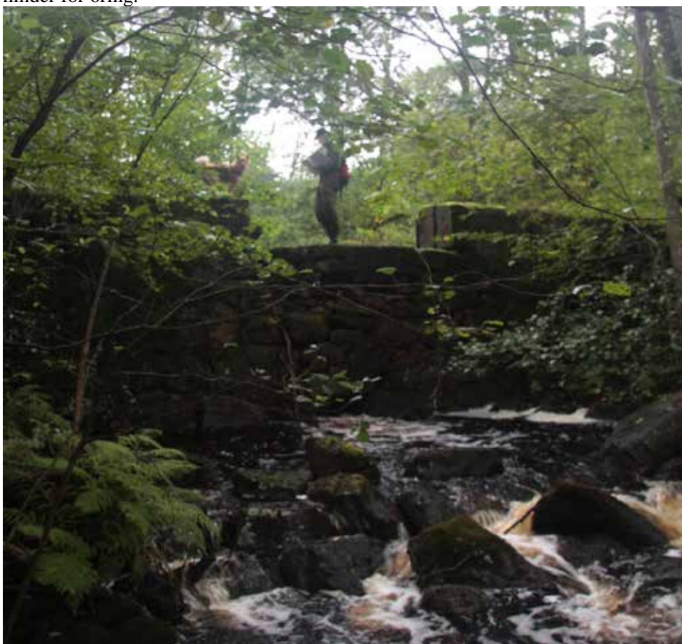
Figur 15. Hinder 1 i Svartåbäcken är ett artificiellt och partiellt nider för öring. Hindret rensas med jämna mellanrum för att upprätthålla passerbarheten för fisk. I mitten av bilden syns det igensatta utskovet (Jonatan står på det) och den lilla öppning som finns för fisken att ta sig igenom, rakt nedanför Jonatan syns en liten svart öppning.
