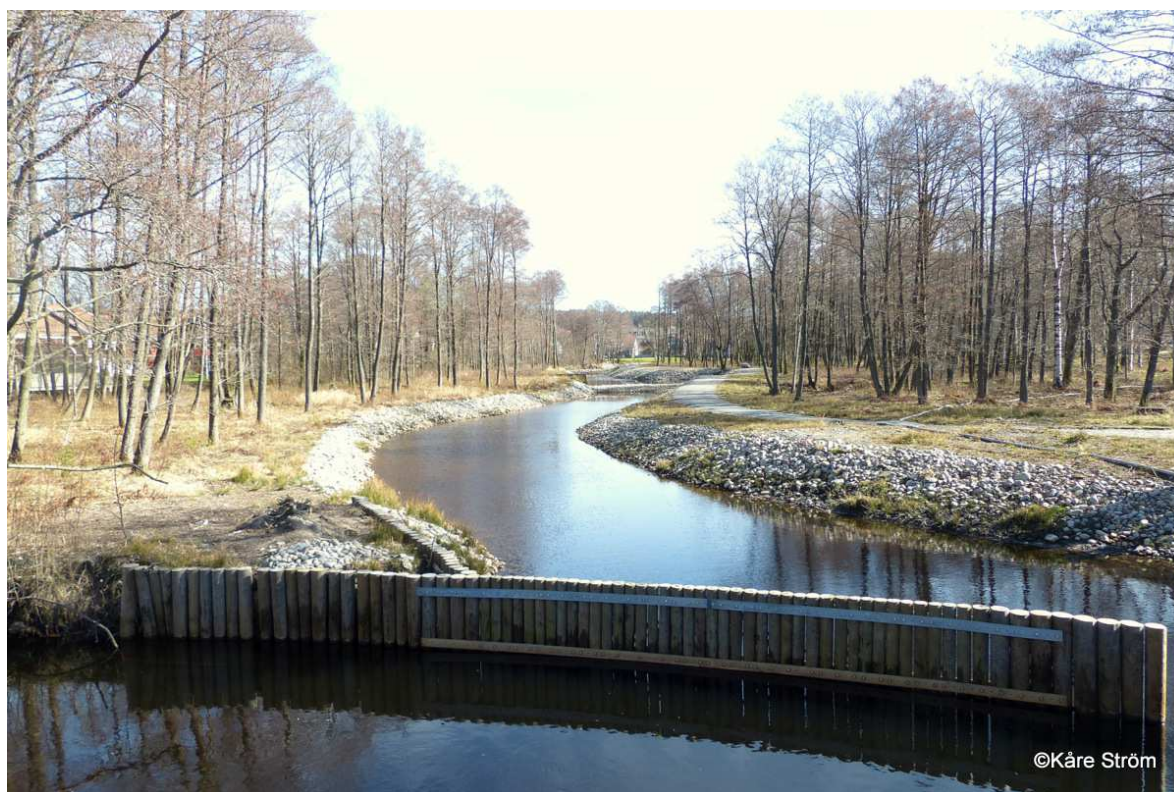
Fig.3. Extrafåra med stenskoning och nyanlagt promenadstråk på delsträcka II, mellan Kyrkvägen och Stationsvägen i Mölndalsån i Landvetter. Foto: Kåre Ström
