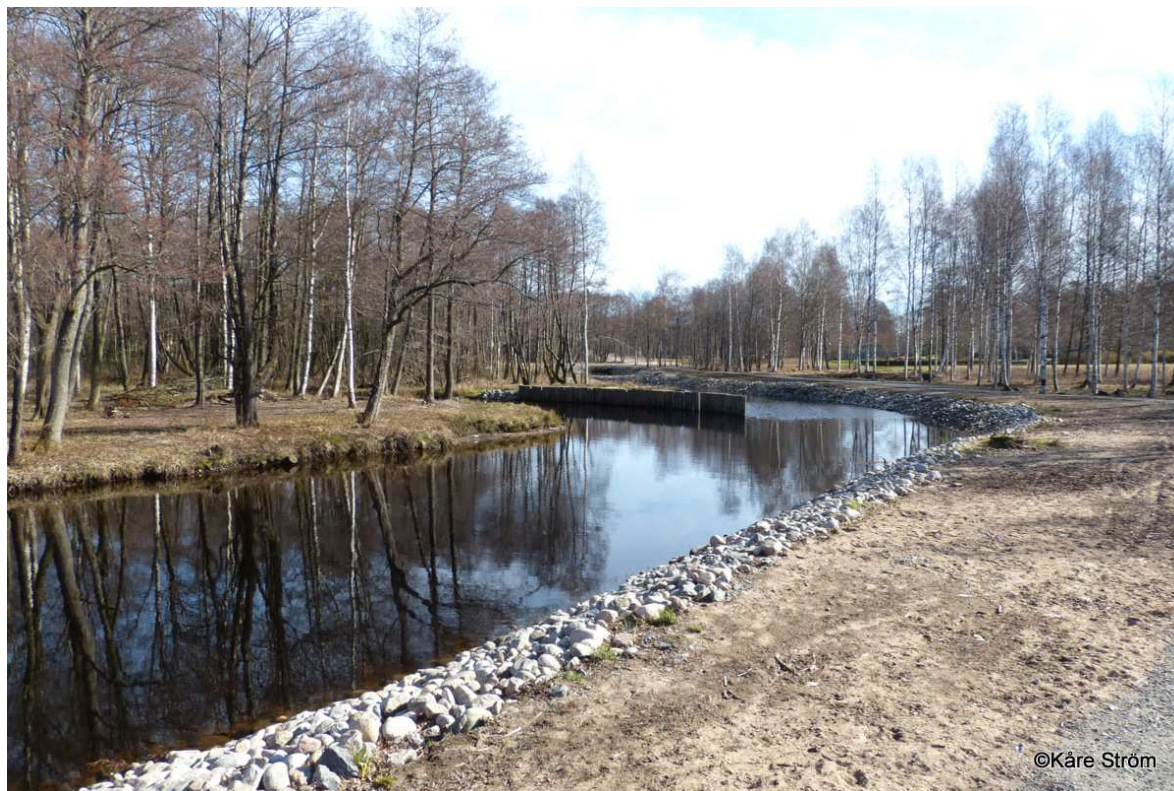
Fig.2. Extrafåra eller "shunt" samt stenskoning på delsträcka nr I i Mölndalsån, mellan Kyrkvägen och utloppet i Landvettersjön. Foto: K. Ström
