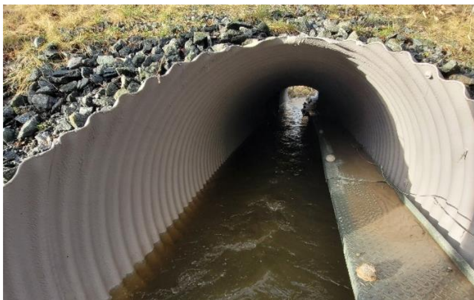
Figur 7 En heltrumma med bottenstrat och djurpassage som korresponderar med storleken på vattendraget.
