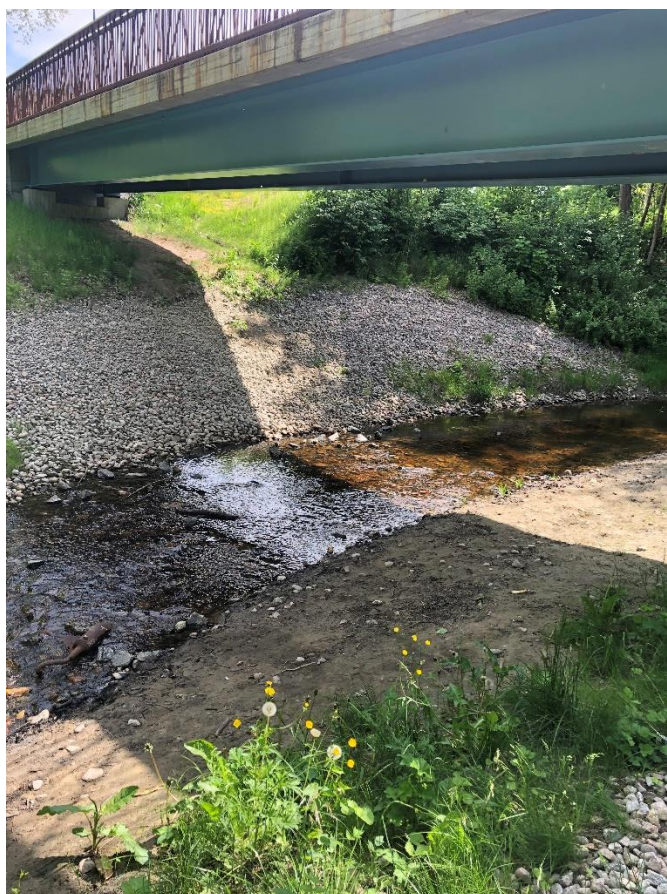
Figur 2 Bro med bibehållet svämplan som kan fungera torrskodd passage för däggdjur.
